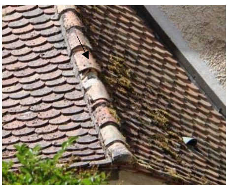
Couverture de la chapelle Tuile d'arétier absente
