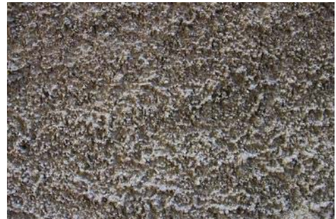
Enduit projeté au ciment
