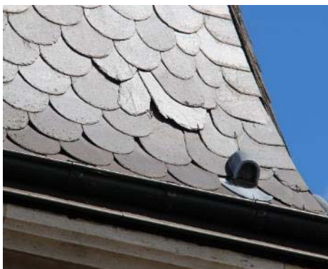
Défaillance de l'ardoise écaille de l'escalier – zone très difficile d'accès pour l'entretien
