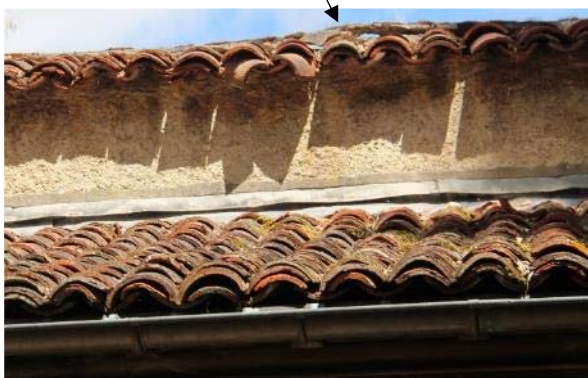
Portique du jardin – couverture en tuile canal ; défaillance de la rive avec la mitoyenneté
