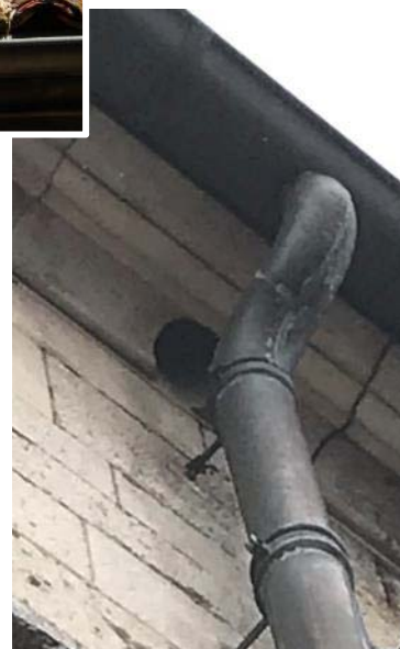
Percement de l'ancien système d'écoulement
