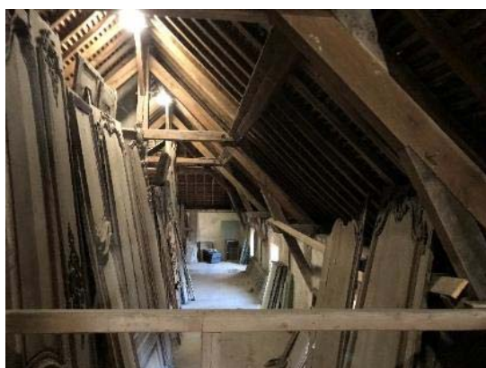
Bâtiment sur cour – appuis des fermes par jambes de force
