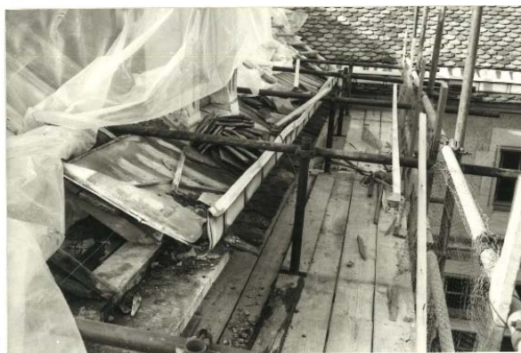
Comble sur la cour, avec la gouttière ardennaise
