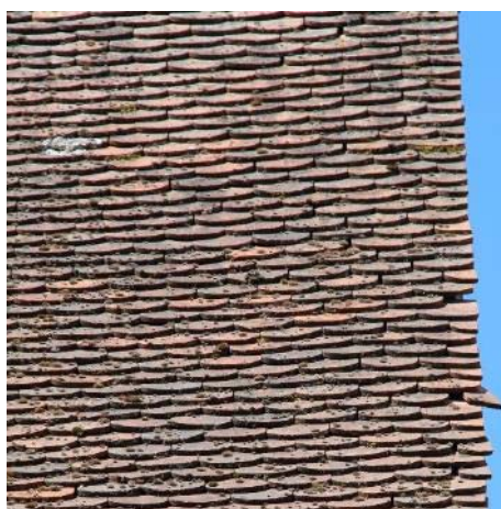
Versant est du bâtiment sur jardin tuiles manquantes sur le versant et en rive
