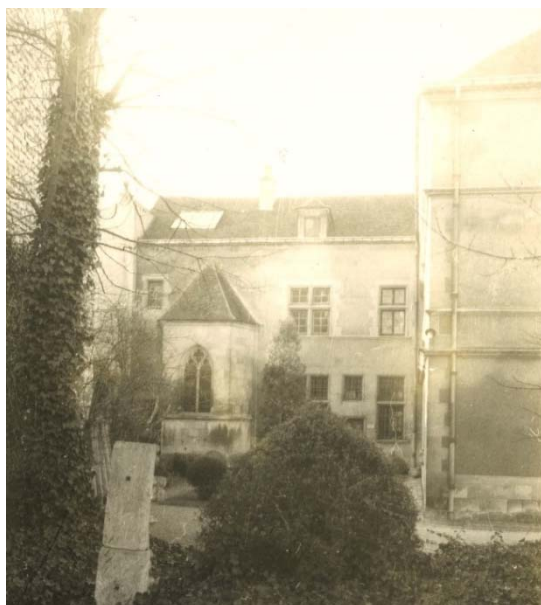
Photographies des façades sur jardin avec l'ancienne gouttière ardennaise - devancée de deux rangs de tuiles, avant les travaux de restauration des couvertures en 1980, archives Michel Goutal.
