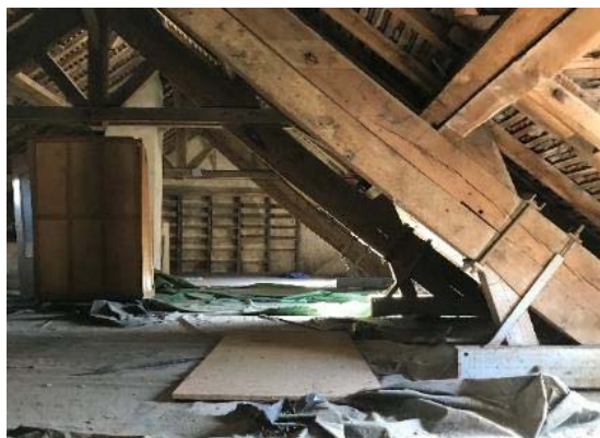
Charpente du bâtiment sur rue (ferme asymétrique)
