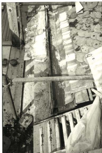
Comble sur rue, avec la gouttière engravée
