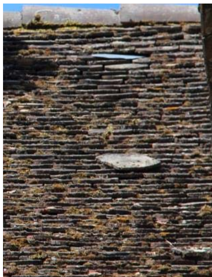
Bâtiment rue de la Belle vierge : Couverture en tuile de récupération
