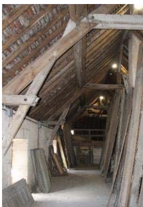
Bâtiment sur cour – appuis des fermes par jambes de force
