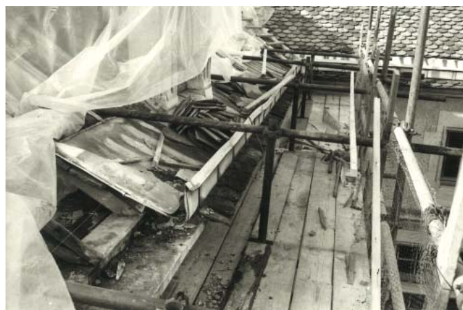
Comble sur la cour en cours de travaux avec gouttière ardennaise, 1972 © entreprise Hory.
