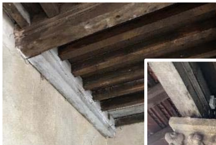
Galerie est – poutre de réemploi à l'angle avec la partie reconstruite
