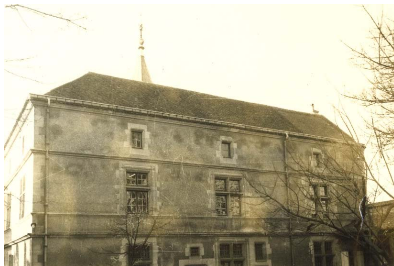
Photographies des façades sur jardin avec l'ancienne gouttière ardennaise - devancée de deux rangs de tuiles, avant les travaux de restauration des couvertures en 1980, archives Michel Goutal.
