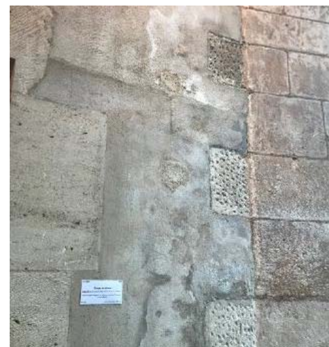
Intérieur de la chapelle – efflorescences salines sur l'enduit
