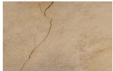
Enduit taloché à la chaux de la galerie
